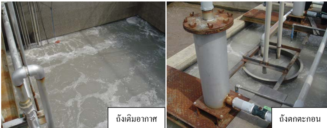
ภาพที่ 12 แสดงส่วนประกอบของส่วนที่หนึ่งของระบบบำบัดน้ำเสียด้วยแบคทีเรียสังเคราะห์แสง
